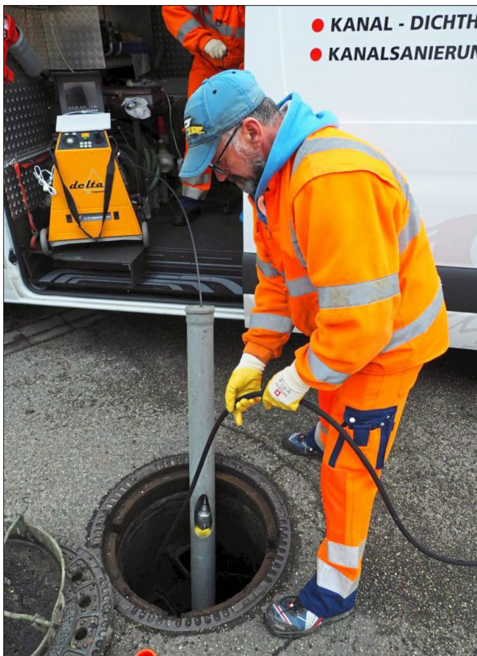
EIN MITARBEITER des Acherner Unternehmens Kress bei der Rohrreinigung. Bei der Firma häufen sich Klagen über unseriöse Anbieter. Foto: rb
